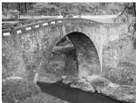
緑川に架かる石橋「霊台橋」
