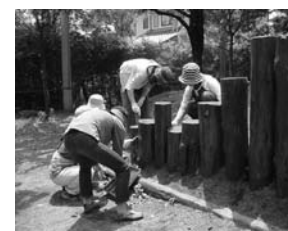
【固定施設のメンテナンス】
